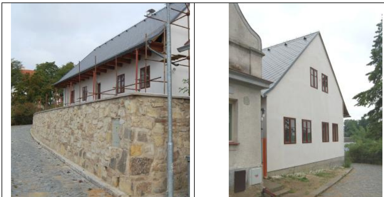
Vkusně provedená novostavba na místě vyhořelého č.p.162.
