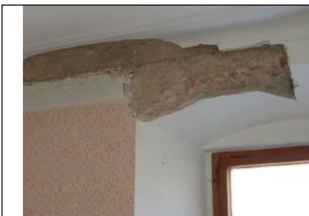
Statická porucha – odklánění štítu
