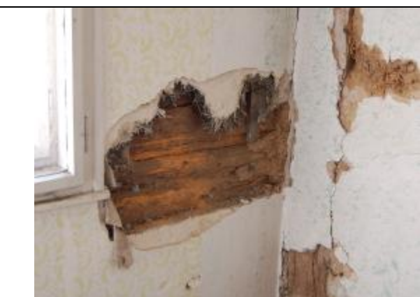
Poškozená trémová konstrukce
