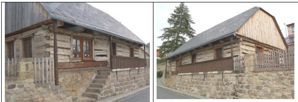
Kvalitně, ale bohužel velmi pomalu prováděná rekonstrukce č.p.163.
