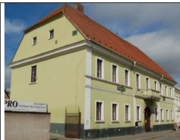
Stávající stav fasády – uliční pohled
