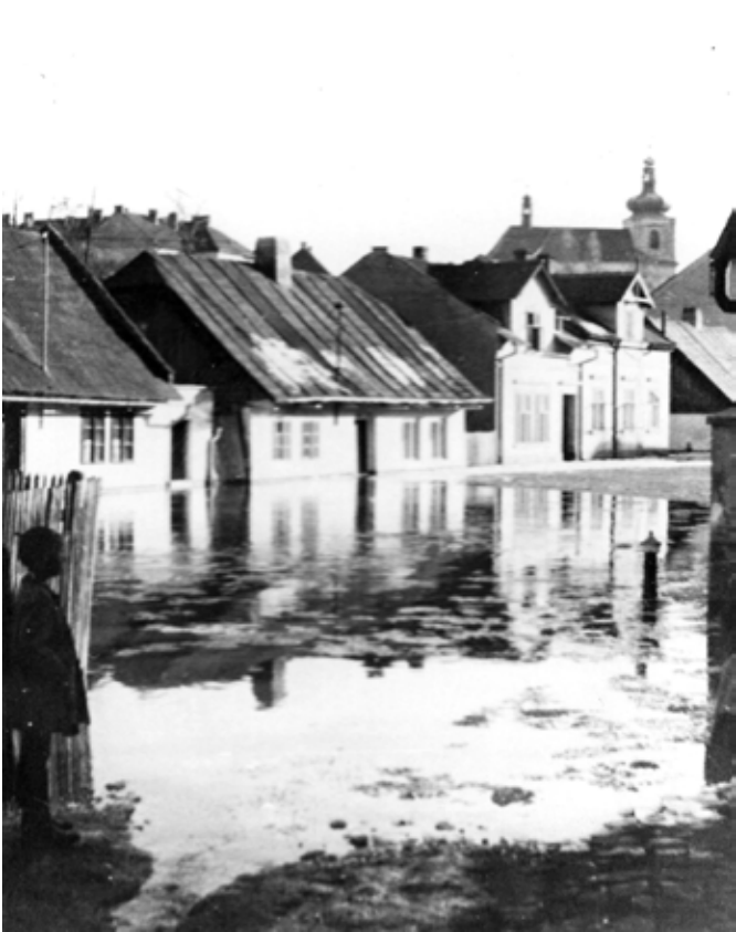
Březen 1947. Rozvodněná Nedbalka zatopila ulici Na Příkopech.
