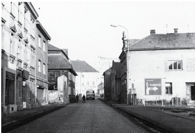
Domy v ulici Víta Nejedlého před demolicí.
