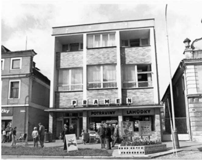
V novém domě na náměstí našly zázemí potraviny o dvou patrech.
