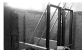
Průběh rekonstrukce na gymnáziu.
