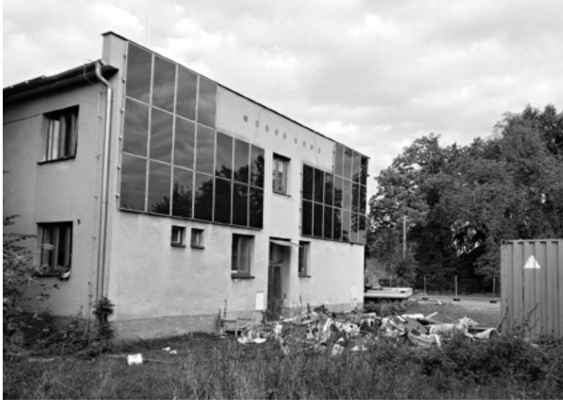
Souběžně s vystěhováním nájemníků došlo k úklidu nepořádku okolo ubytovny.
