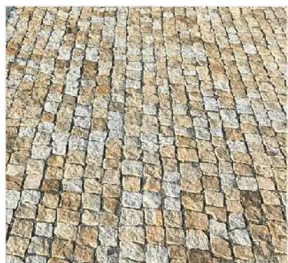
DLAŽBA ŽULOVÉ KOSTKY
