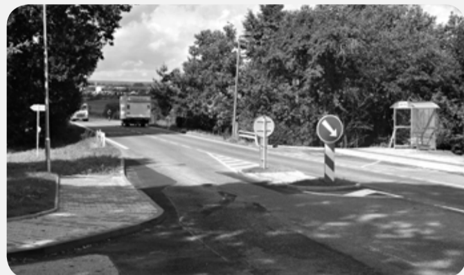
Proměna křižovatky v Dobré Vodě. Stav před a po stavebních úpravách.
