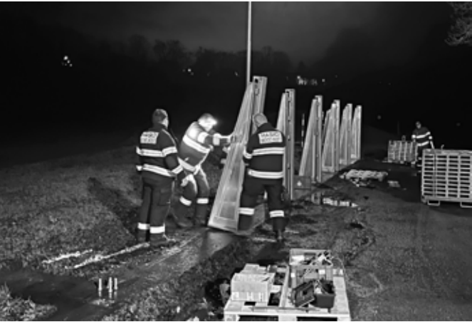
Prosincová stavba protipovodňové hráze byla nakonec ostrou zkouškou.
