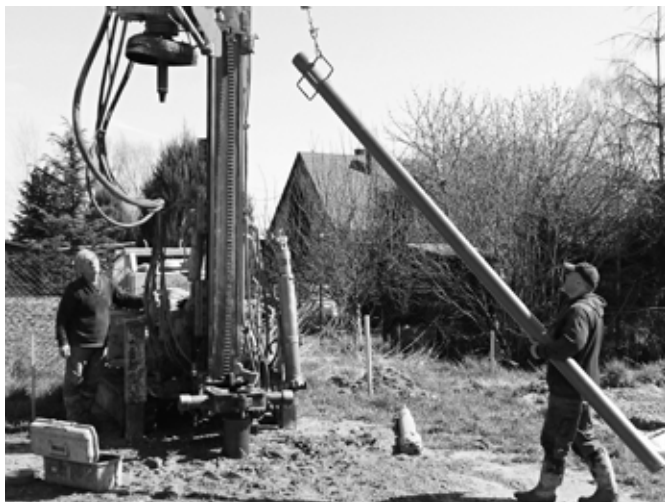
Vystrojování nově budované vrtané studny PVC zárubnicemi.
