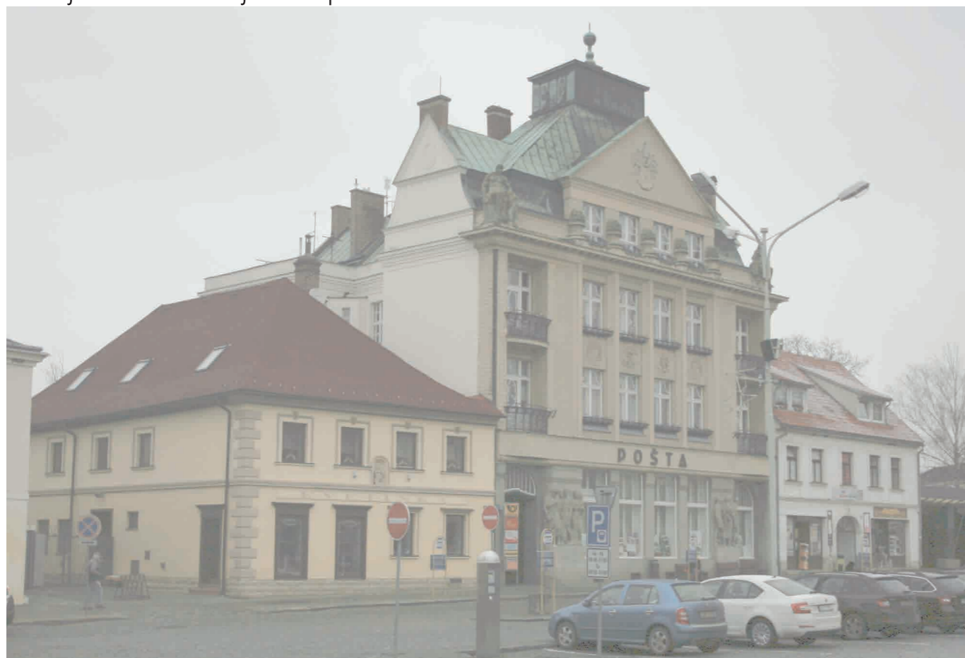
FOTO stávajícího stavu objektu č.p. 239
