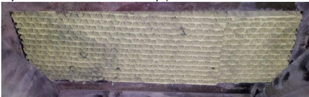
Obr. 4 Ustavení katalyzátoru v místě nad ohništěm (pohled zespod)
