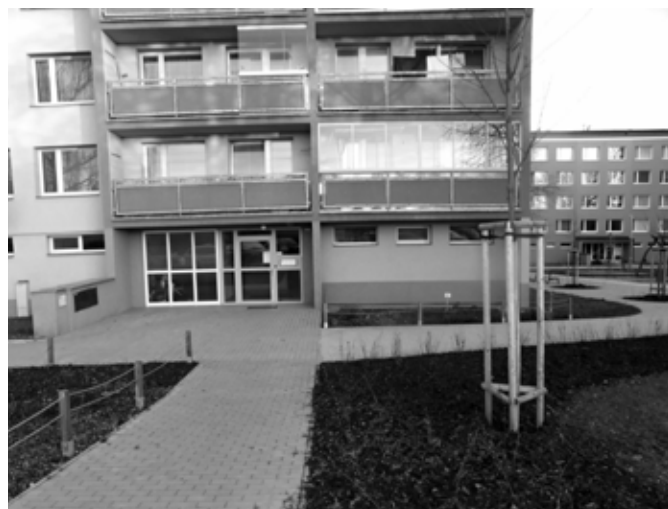
V podobném duchu jako na snímku bude probíhat rekonstrukce sídliště Jaselská také v letošním roce.
