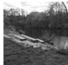
VÝMĚNA PRKEN NA KAMÍNKÁCH Pavel Břicháček
