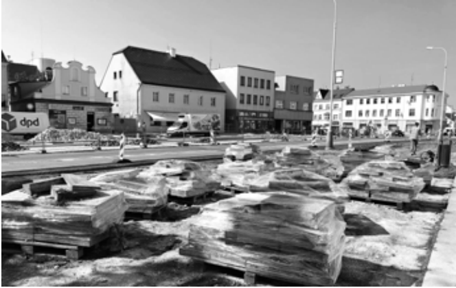
Stará dlažba odstraněná z prostoru před hlavním vstupem do radnice sbalená před odvezením. V rámci úsporného nakládání se stavebním materiálem bude v budoucnu využita v jiné části města.
