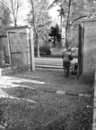
Práce na dláždění ve vozové bráně.
