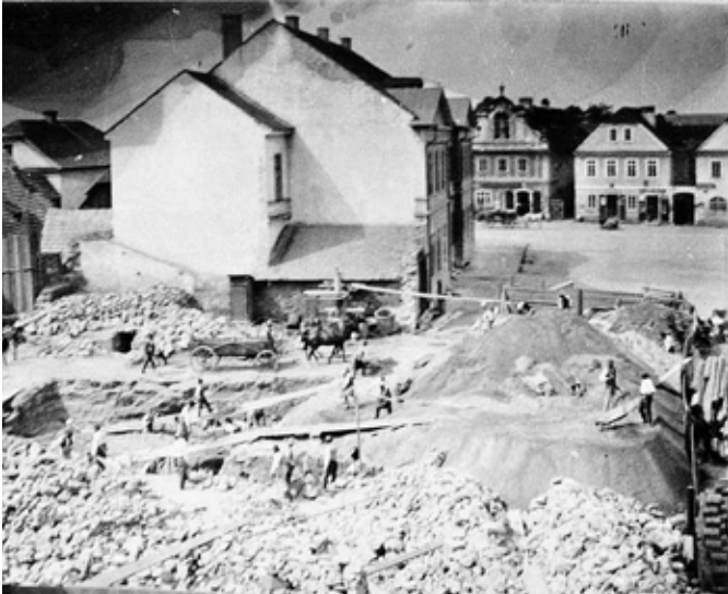
Snímek staveniště nové radnice.
