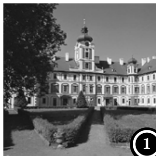
ZÁMEK MNICHOVO HRADIŠTĚ
