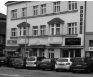
Dům čp. 8 v ulici Víta Nejedlého.
