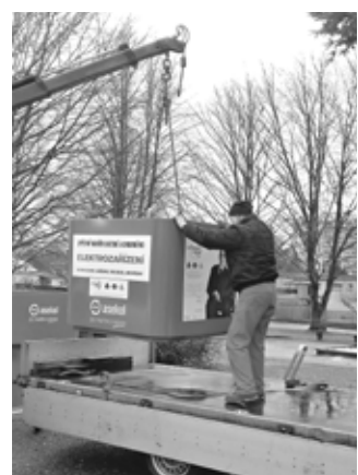
Instalace kontejnerů na místo.
