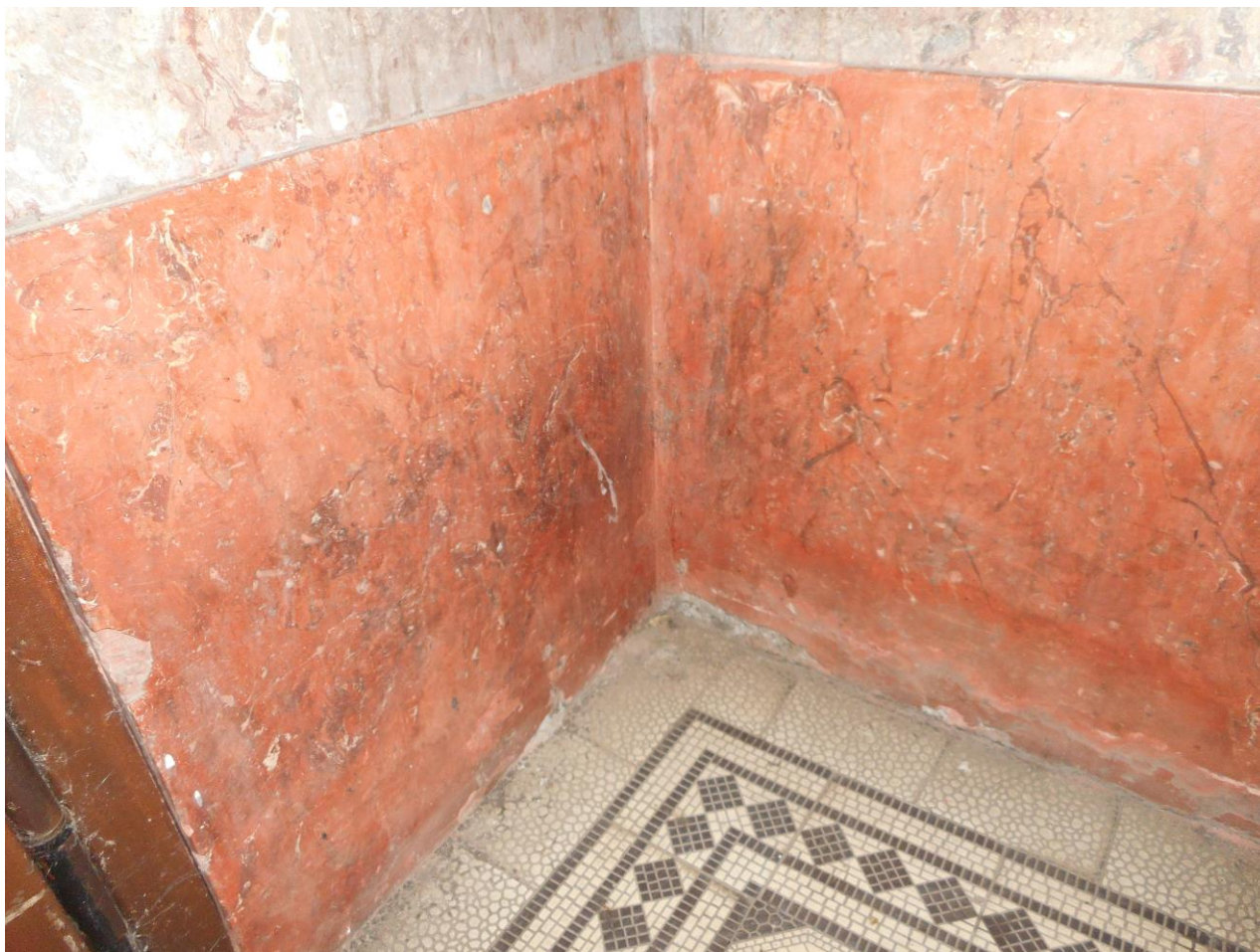
Detail č. 17 postihující defekty soklu
