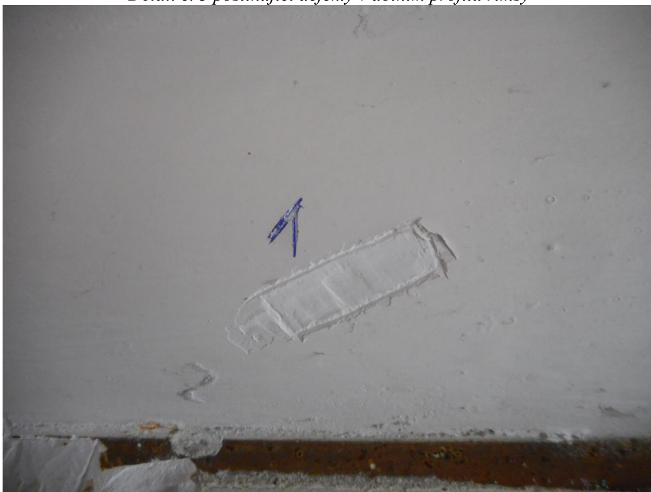
Detail č. 4 postihující sondu č. 1 provedenou v sádrové římse
