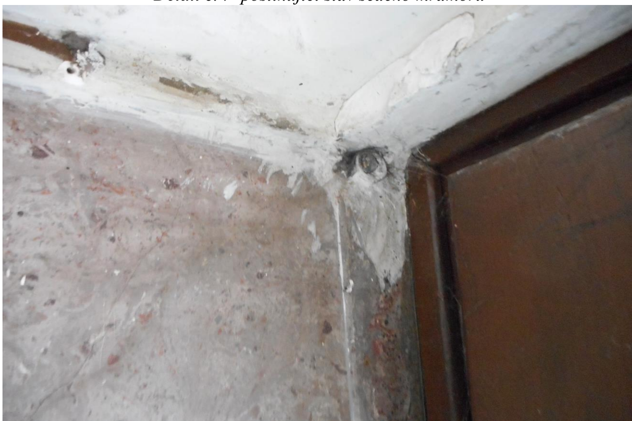
Detail č. 8 postihující defekty v šedém mramoru a štukové římse vzniklé vedením kabelu
