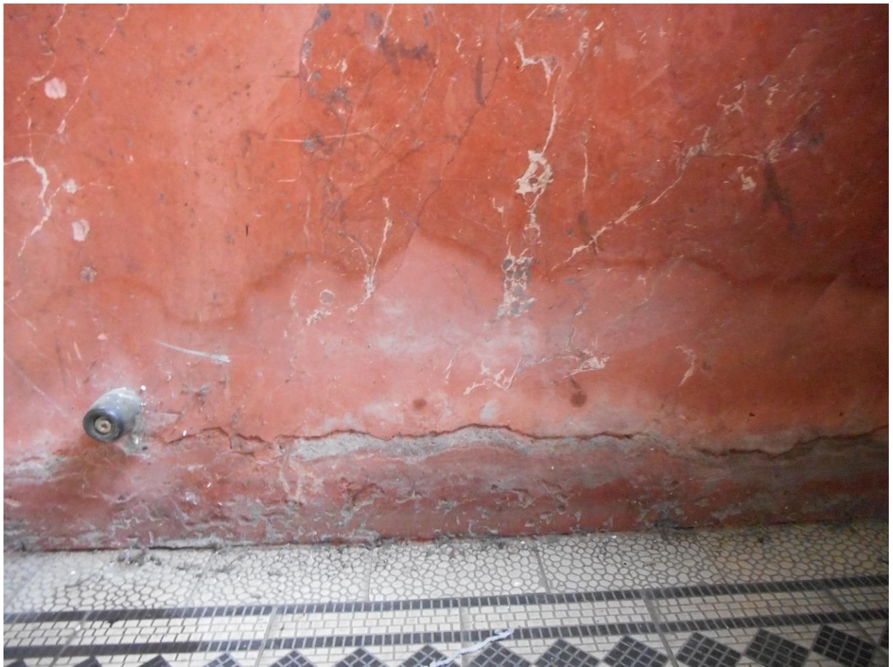
Detail č. 15 postihující defekty soklu
