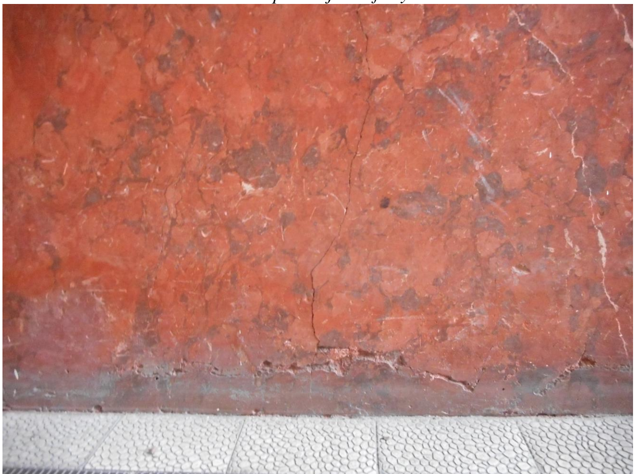
Detail č. 16 postihující defekty soklu
