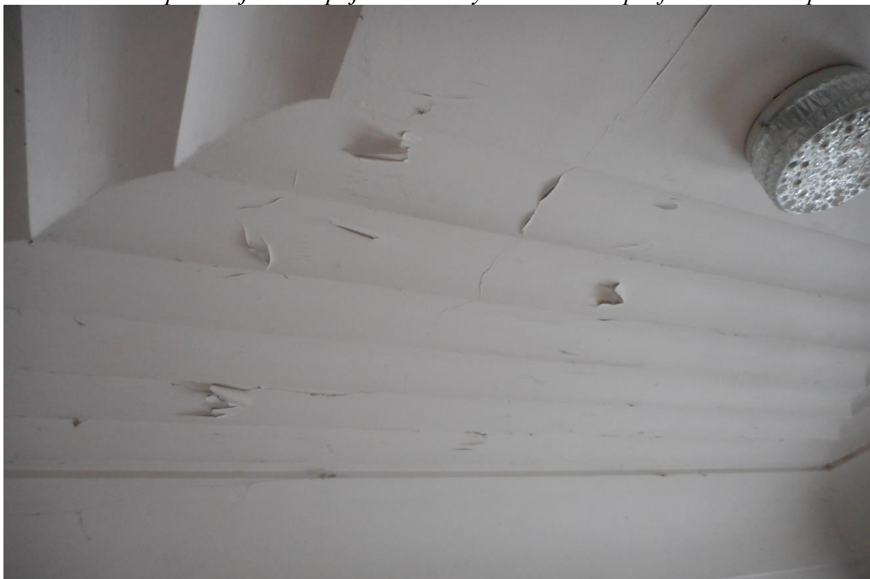
Detail č. 2 postihující odlupující se nátěry na štukovém profilovaném stropě
