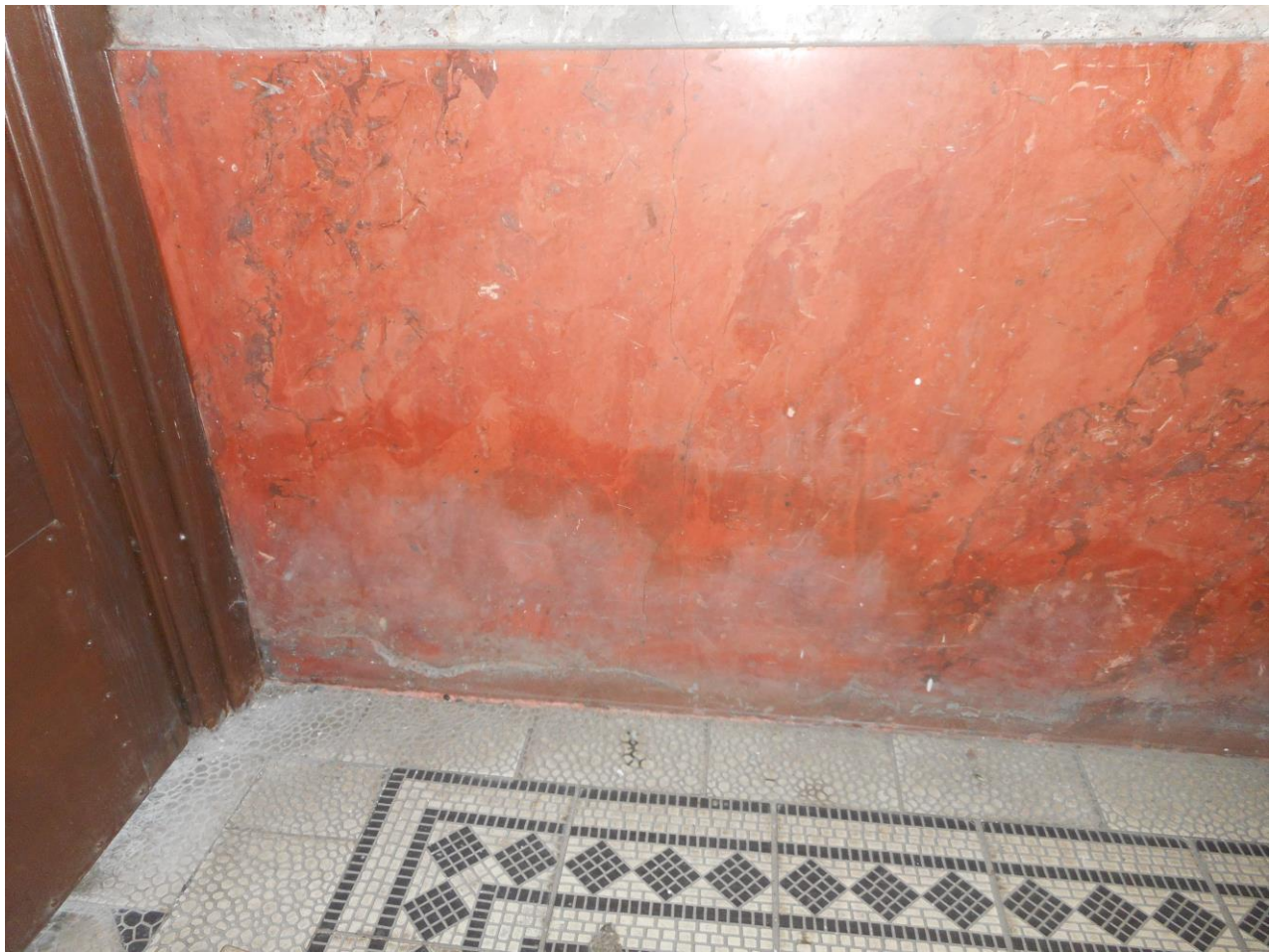
Detail č. 19 postihující defekty soklu
