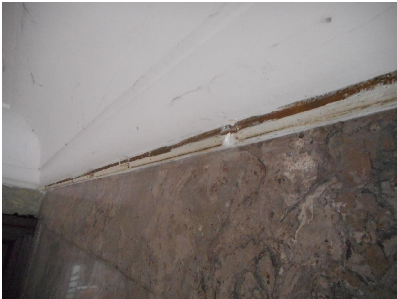
Detail č. 3 postihující defekty v dolním profilu římsy
