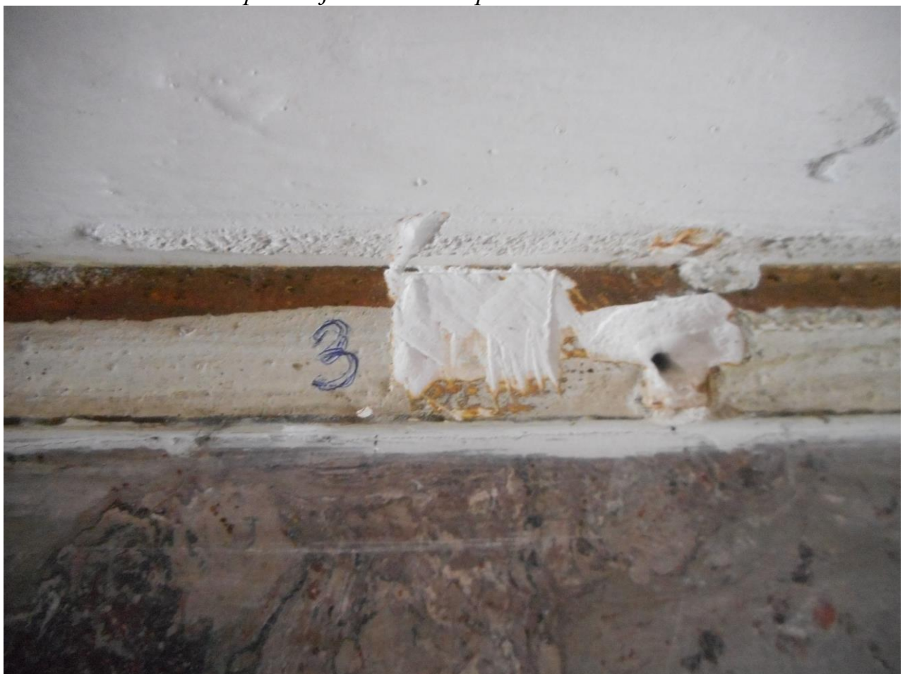
Detail č. 6 postihující sondu č. 3 provedenou v sádrové římse
