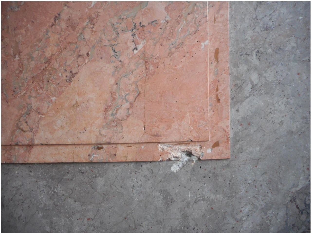
Detail č. 11 postihující defekt v růžovém dekorativním poli
