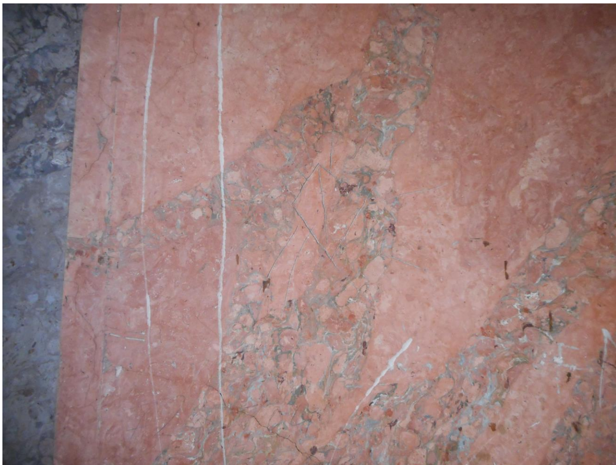
Detail č. 13 postihující poškození levé růžové dekorativní plochy vrypy
