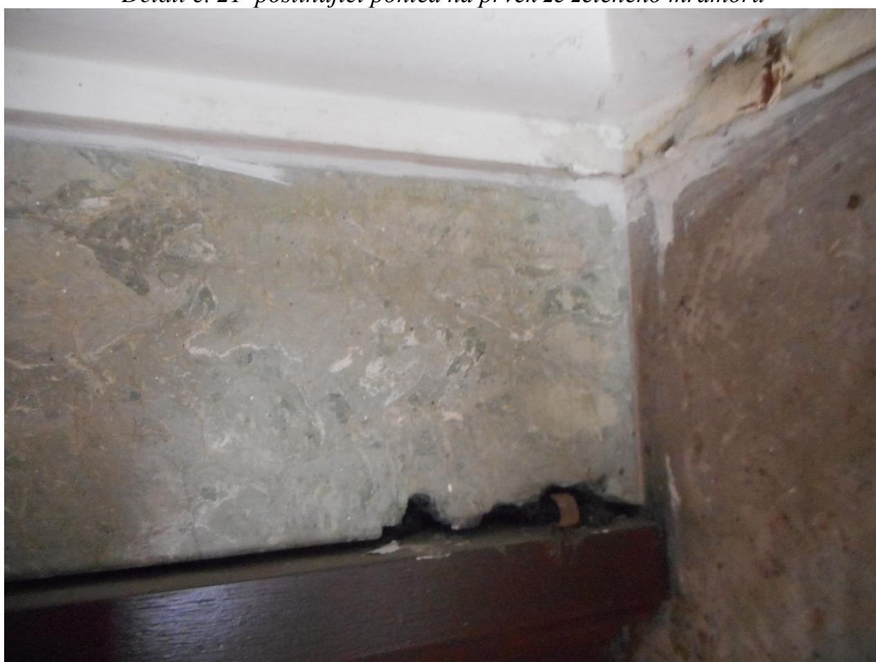
Detail č. 22 postihující defekt v zeleném mramoru po vedení kabelu
