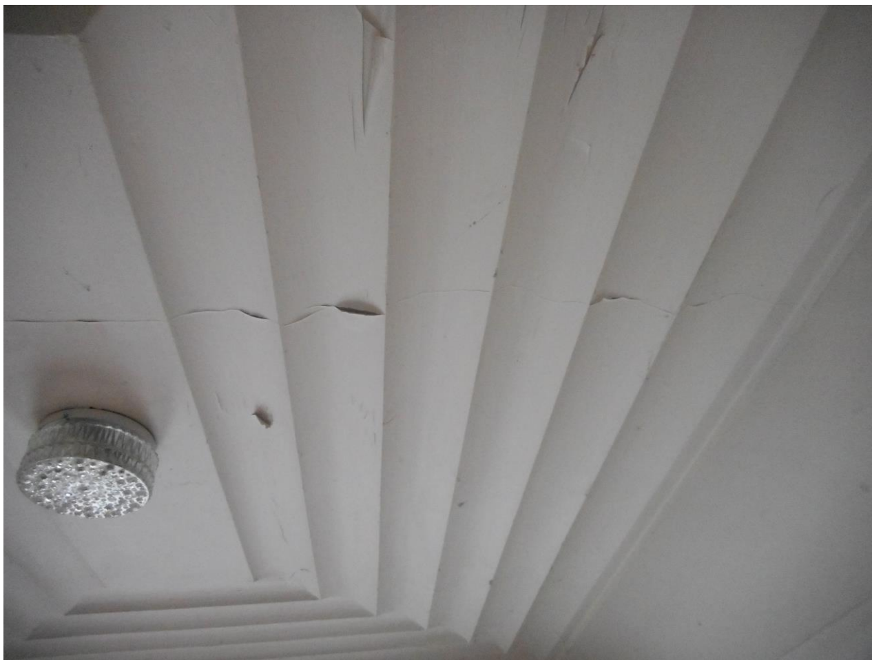
Detail č. 1 postihující odlupující se nátěry na štukovém profilovaném stropě
