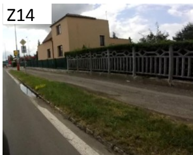
Bariérový chodník v ulici Víta Nejedlého /nerovnosti pochozí plochy/.
