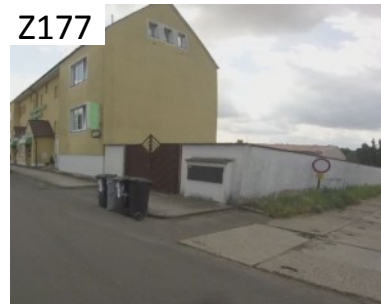
Bariérový úsek v Jiráskově ulici /nerovnosti, nesnížené obrubníky/.
