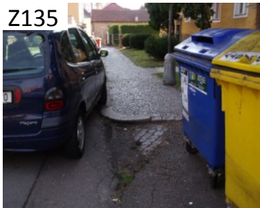
Bariérový úsek chodníku ve Studentské ulici /nedostatečně snížený obrubník, nerovnosti a zúžený průchod/.
