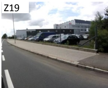
Bezbariérový chodník v ulici Víta Nejedlého.
