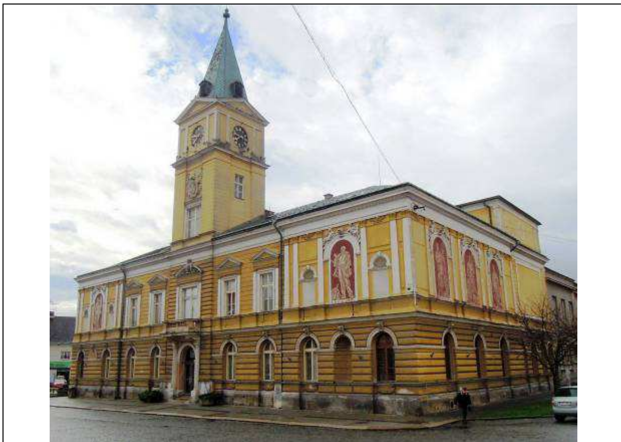
Objekt č.p. 1 – radnice – historický objekt na exponovaném místě.
