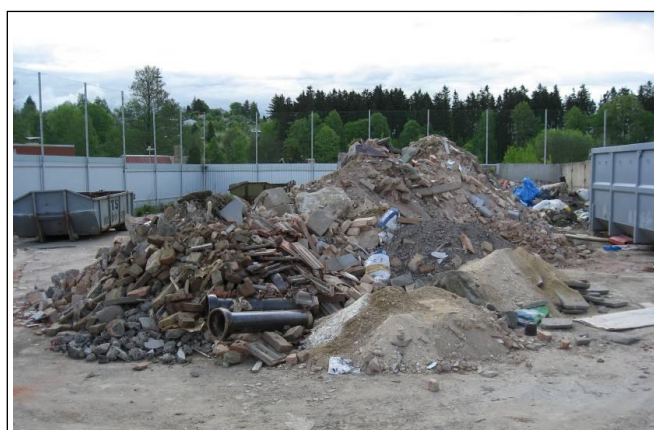
Obrázek G1- Stavební a demoliční odpad – ilustrační foto.
