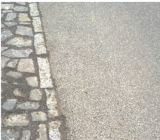
Přechod asfalt, kamenný lem a parkování (štetová dlažba)
