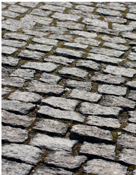
Ukázky dlažby z kočičích hlav s použitím různých druhů kamenů
