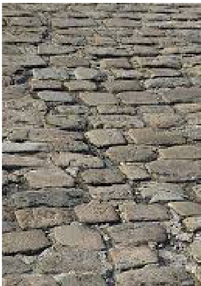
Ukázky dlažby z kočičích hlav s použitím různých druhů kamenů
