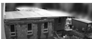
Průběh stavby nového pavilonu lze sledovat prostřednictvím online kamery na stránkách firmy MH2net.
