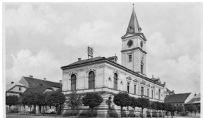
Také radniční budova je dílem firmy Františka Dávce.
